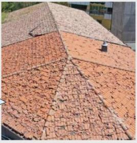
Tetto integralmente danneggiato: tutti i coppi da sostituire
